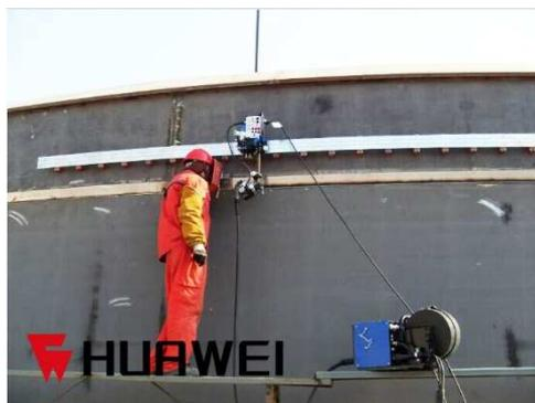
Полуавтоматический сварочный комплекс НК-100S предназначен для сварки горизонтальных швов на вертикальной плоскости крупногабаритных металлоконструкций. Применяется для сварки поясных швов при сварке листов обшивки корабельных корпусов, монтаже резервуаров, сосудов и емкостей в химической, пищевой, цементной промышленности.
